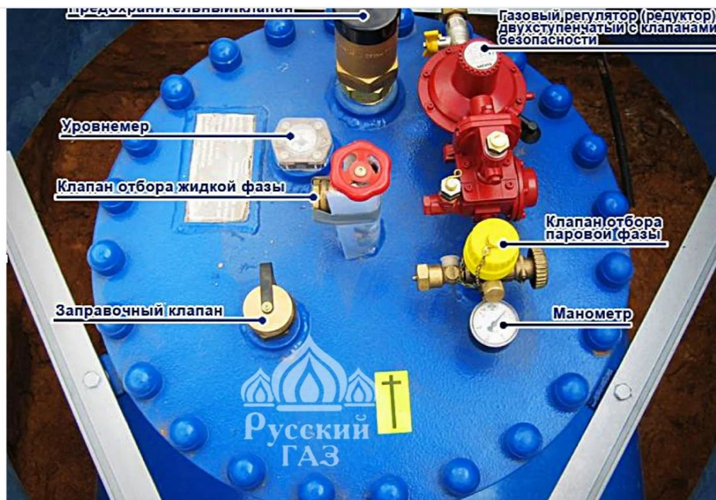
Основные предохранительные элементы системы автономной газификации
